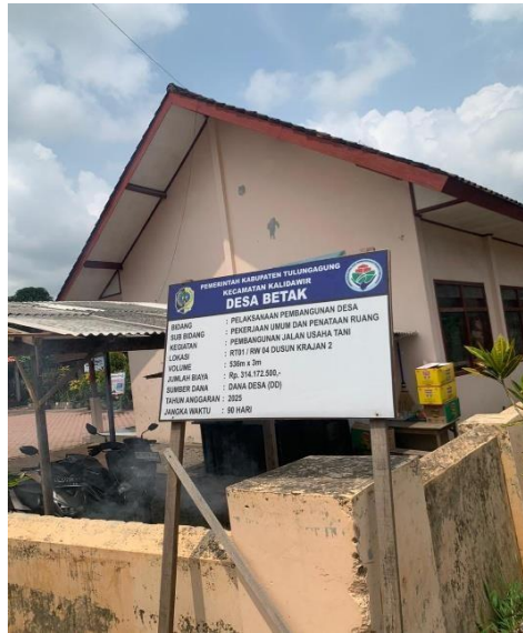
Gambar 1. Papan Informasi Proyek Pembangunan Jalan Desa Betak
